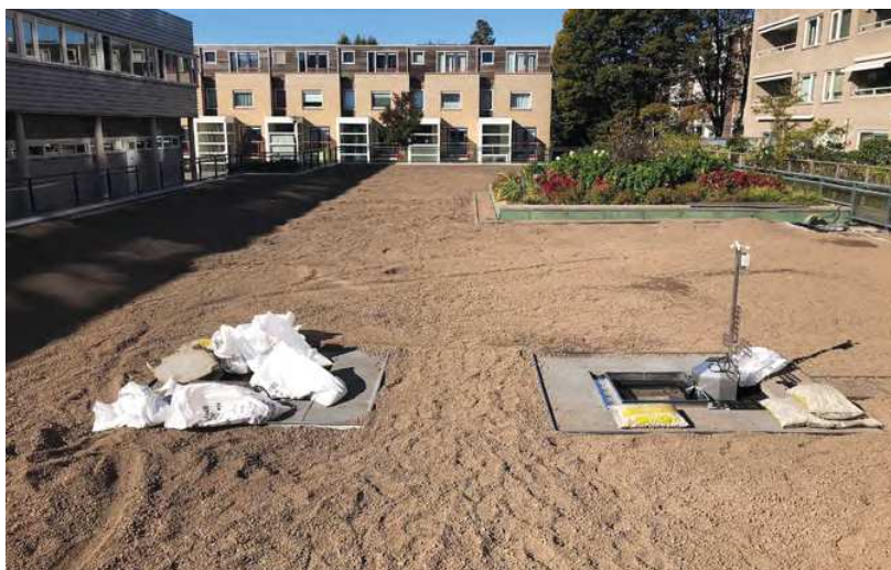
Aanbrengen van de substraatlaag op het dak van de parkeergarage
