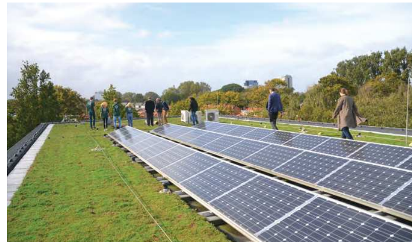
Het groendak met zonnepanelen op het dak van de Daltonschool
