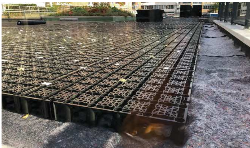
Opbouw van het polderdak op de parkeergarage
