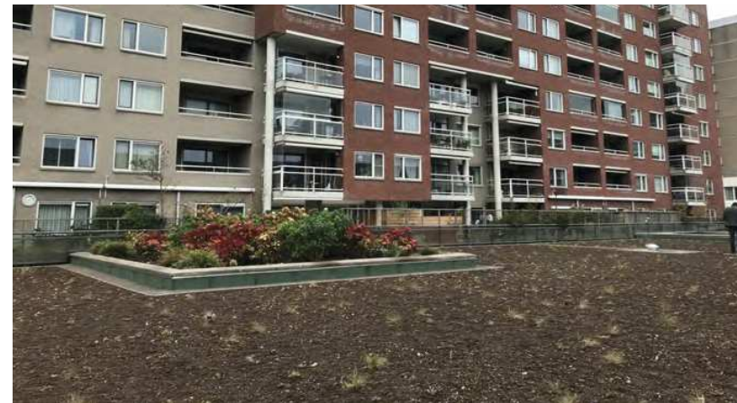
Het polderdak op de parkeergarage net na realisatie. De beplanting kan nu gaan groeien
